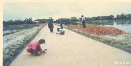
Fig: Laying of JGT
