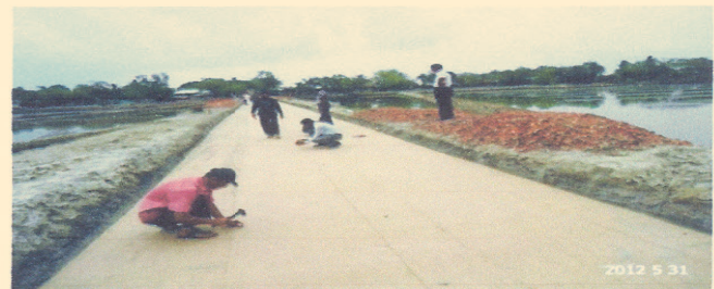
Fig: Laying of JGT
